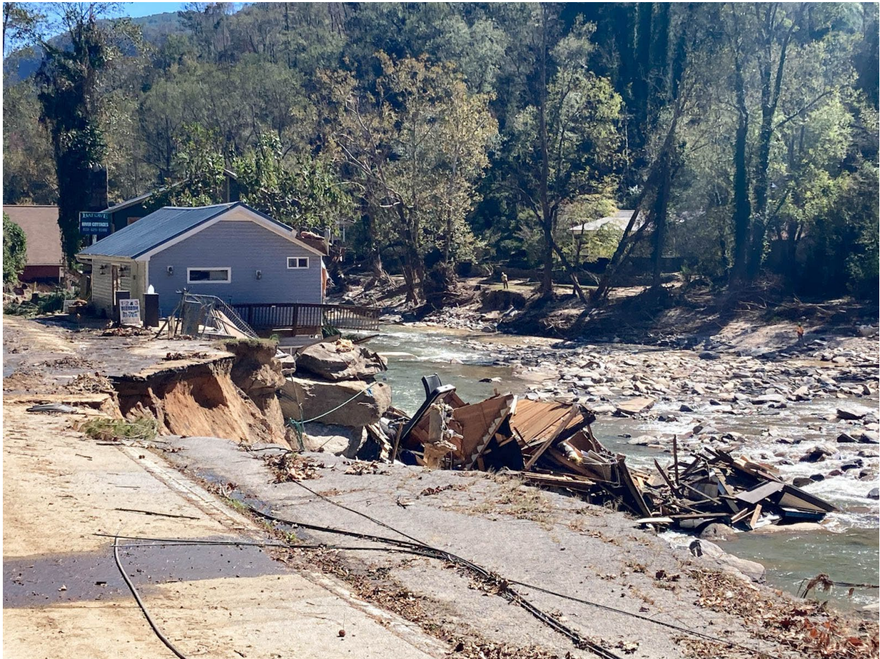
Figura 11: Daños por inundación a lo largo de US Route 64, Bat Cave, NC, 10 de octubre de 2024. Crédito: NCDOT
